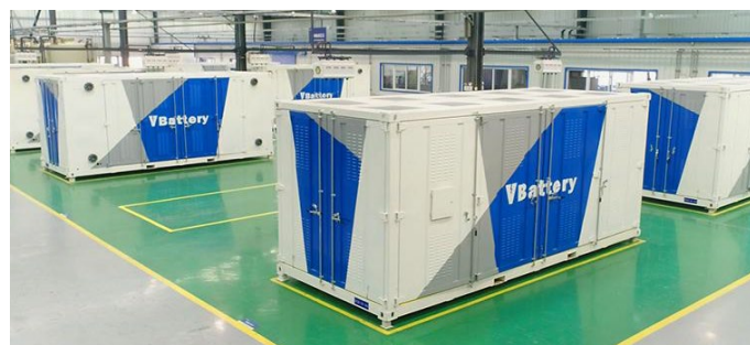
100MW/400MWh全钒液流电池储能电站
