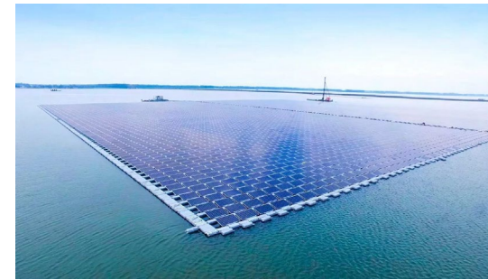
水面漂浮式光伏电站
